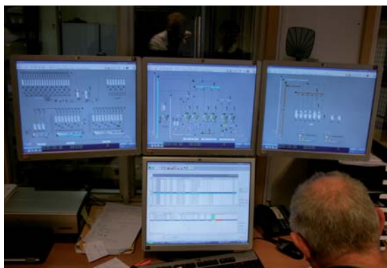
Het totale productieproces is geautomatiseerd door ITH
